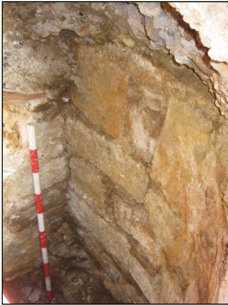
FOTO 1. Vista de detall de la zona de contacte entre la fossa sèptica UE 13 i el mur UE 09 (Rasa 2).
