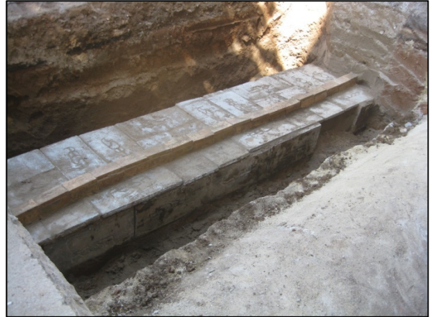
FOTO 22. Detall del cablejat de mitja tensió situat a l'interior de la rasa 7 (corresponent a un dels sobreixidors previstos en el projecte d'obra).
