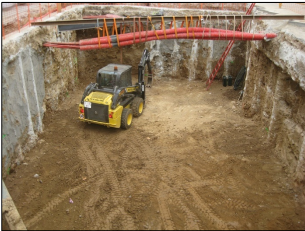
FOTO 11. Vista general del rebaix corresponent a la rasa 2.
