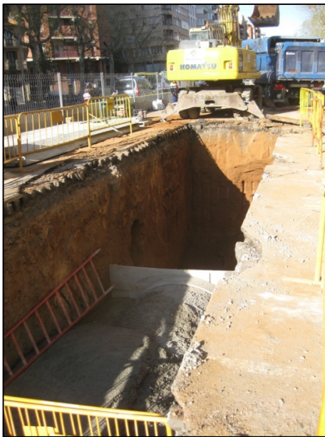
FOTO 15. Detall del procés de realització de la rasa 1.
