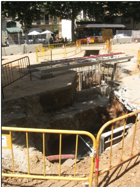
FOTO 23. Vista general de la rasa 8 (corresponent a un dels sobreixidors previstos en el projecte d'obra).
