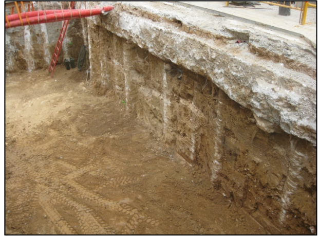
FOTO 10. Vista general de la zona de contacte del rebaix corresponent a la rasa 2 i el dipòsit ja existent.
