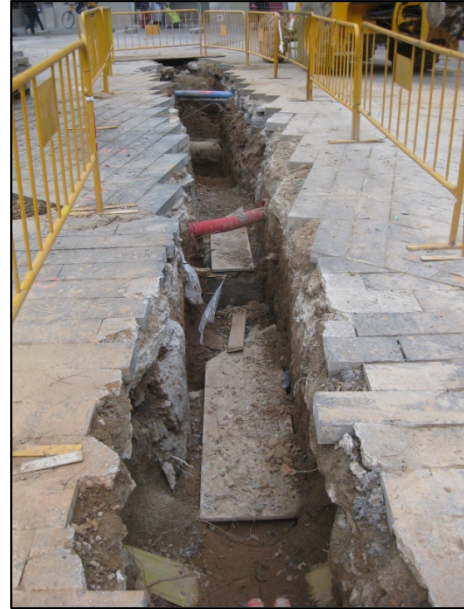
FOTO 30. Vista general de la rasa per a la construcció del mur pantalla corresponent a la col·locació del col·lector (a l'alçada de la Plaça de la Bella Dorita).
