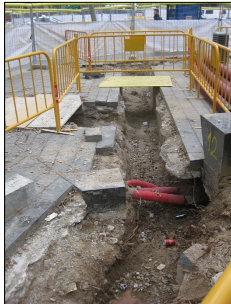
FOTO 28. Vista general de la rasa 3, corresponent al cablejat elèctric.
