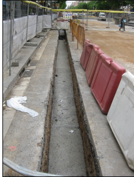
FOTO 26. Vista general de la rasa 4, corresponent al cablejat de telefonia.
