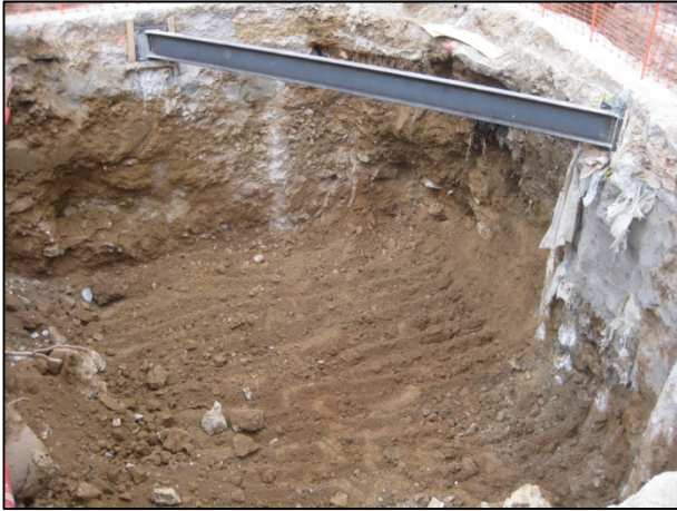
FOTO 9. Vista general del rebaix corresponent a la rasa 2.
