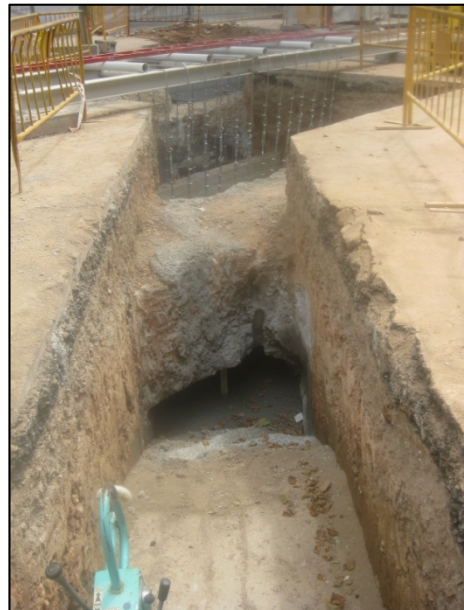
FOTO 24. Vista general de la rasa 8 (corresponent a un dels sobreixidors previstos en el projecte d'obra).
