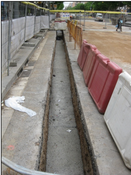
FOTO 27. Vista general de la rasa 4, corresponent al cablejat de telefonia.
