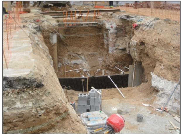
FOTO 14. Tram final del col·lector (rasa 1) a l'alçada de la Plaça de la Bella Dorita.
