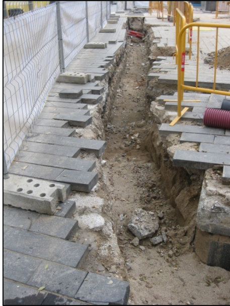
FOTO 29. Vista general de la rasa 3, corresponent al cablejat elèctric.
