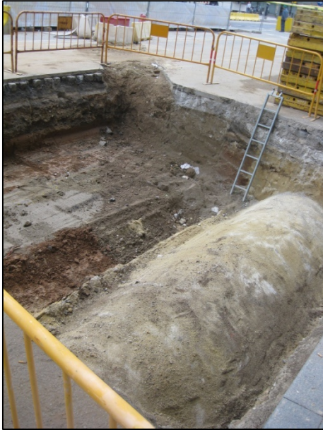
FOTO 25. Vista general del rebaix corresponent a la rasa 7.
