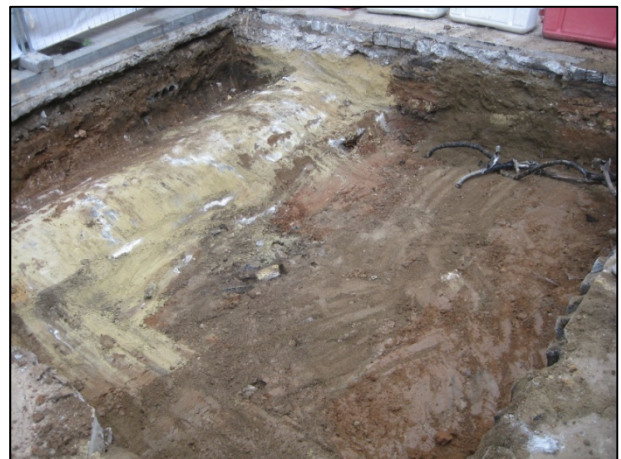
FOTO 20. Vista general de la rasa 6 (corresponents a un dels sobreixidors previstos en el projecte d'obra).
