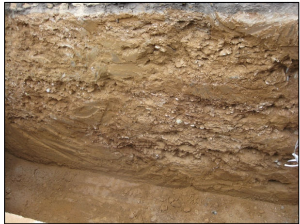
FOTO 12. Detall de l'estratigrafia corresponent a la rasa 1, en el que es pot apreciar l'asfalt (UE 01), l'estrat d'anivellament per a la seva col·locació (UE 02) i el terreny geològic (UE 03).
