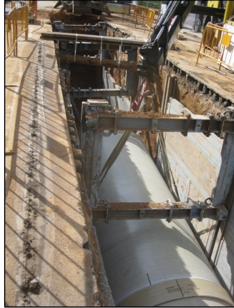
FOTO 34. Procés de col·locació de la canonada del col·lector a l'interior de la rasa 1.
