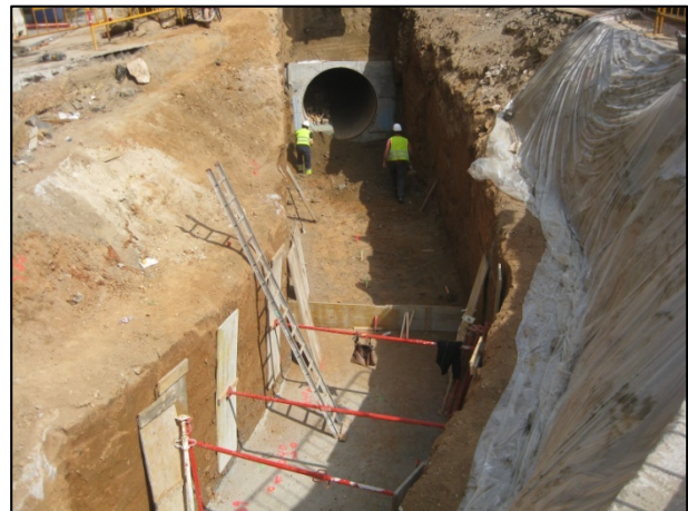
FOTO 36. Zona de connexió entre el col·lector vell i el de nova construcció (rasa 1) prop de la cantonada entre el C. Parlament i l'Av. Paral·lel (a l'alçada de la Plaça dels Ocellets).
