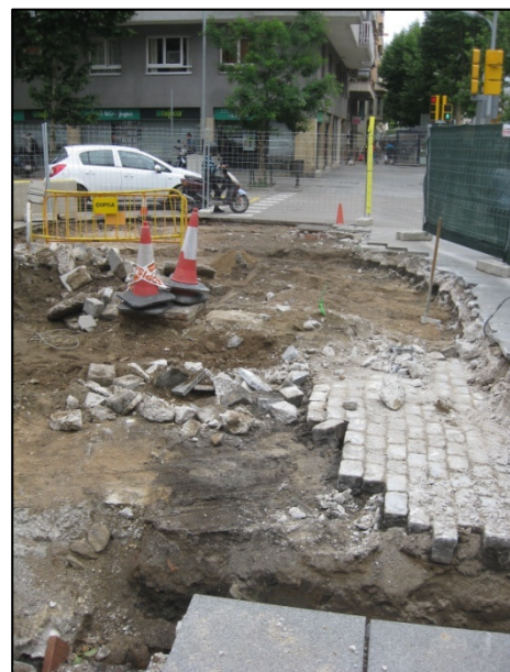
FOTO 32. Vista general del procés d'urbanització de la cantonada del C. del Comte Borrell amb l'Av. del Paral·lel.
