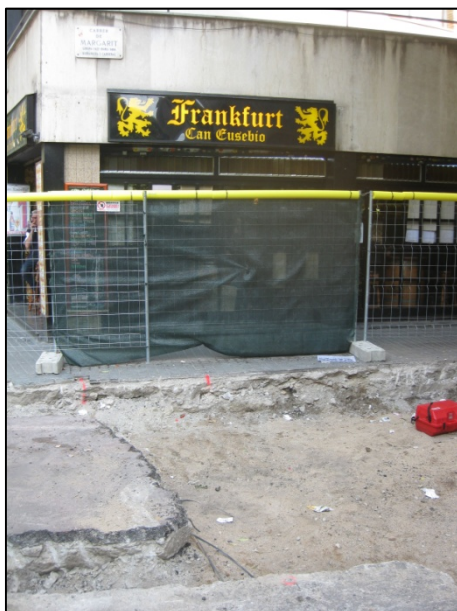
FOTO 31. Vista general del procés d'urbanització de la cantonada del C. de Margarit amb l'Av. del Paral·lel.
