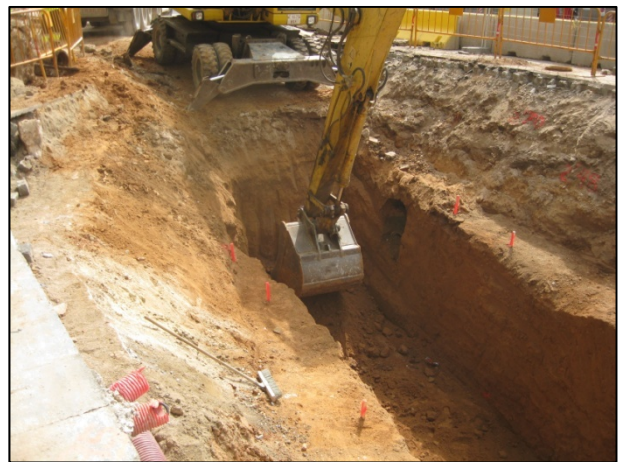
FOTO 16. Detall del procés de realització de la rasa 1.
