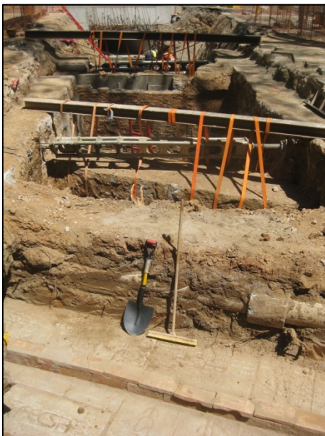
FOTO 35. Vista general dels diversos serveis situats en el traçat de la rasa 1 a l'alçada de la Plaça de la Bella Dorita.
