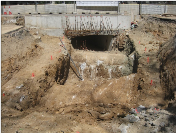
FOTO 13. Tram final del col·lector (rasa 1) a l'alçada de la Plaça de la Bella Dorita.
